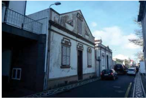
PRESTÍCIO - FACHADA PRINCIPAL
